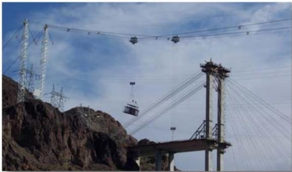
I nostri cavallotti, posti a sostegno delle funi di manovra lungo la linea, consentono di praticare notevoli velocità di traslazione dei carrelli, con una regolarità di esercizio assoluta e riducendo l'usura dei rulli e delle funi, evitando quindi fermate dell'impianto per riparazioni o per manutenzione.
